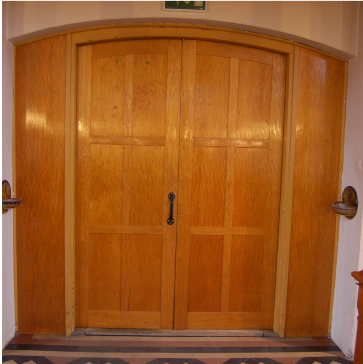
tussendeur bestaat: houten draaiende delen worden vervangen door glas
